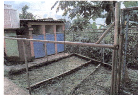
Foto 6: Sustitución de fosa séptica por biodigestor de 1300 Lts. Y Sustitución de tubería PVC línea principal aguas negras
