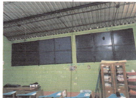
Foto 10: Sustitución de estructura de metal de ventana (por balcón)
