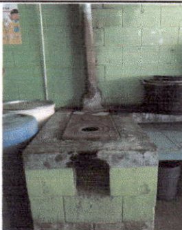
Foto 5: Mantenimiento a estufa rural, Sustitución de plancha de metal de 3 hornillas e Instalación de azulejo en estufa rural
