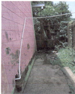
Foto 9: Instalación de tubería para agua potable
