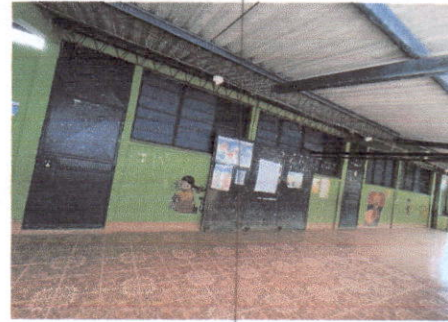
Foto 8: Pintura en muros exteriores e interiores
