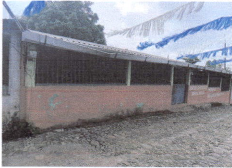
Foto 7: Pintura en muros exteriores e interiores
